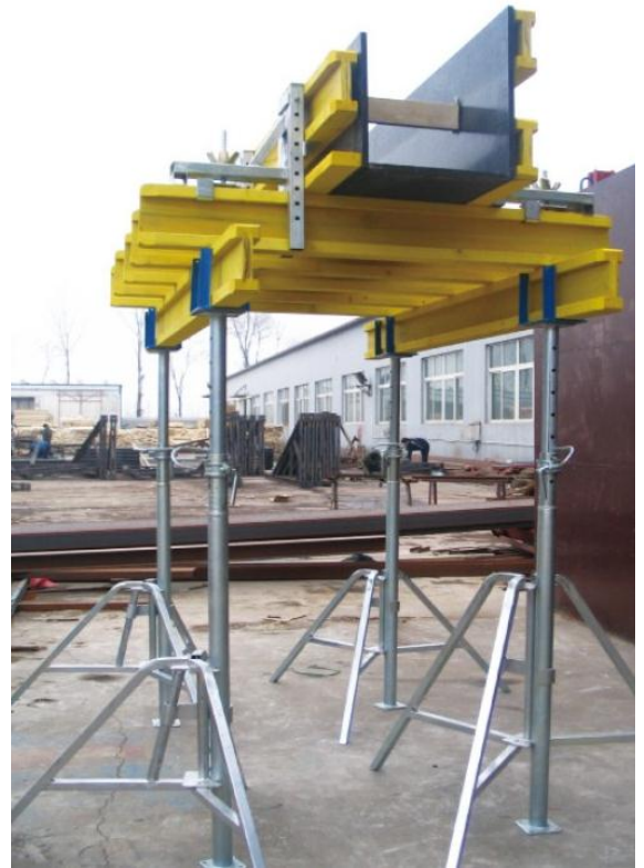
Hệ thanh chống độc lập cho ván khuôn dầm/ Standalone prop system for beam form
