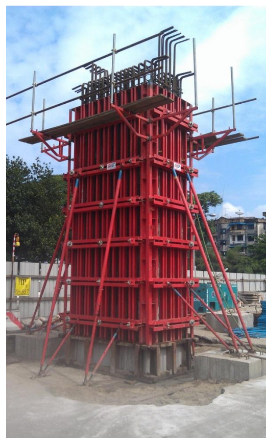
Ván khuôn thép cho trụ cầu hình chữ nhật/ Rectangular Bridge Pier Steel Form
