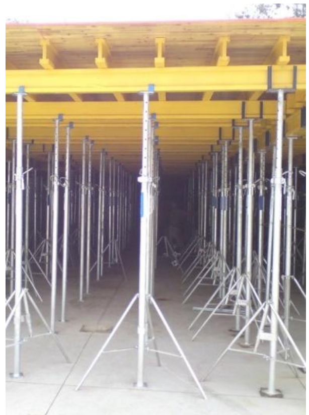
Hệ thanh chống độc lập cho ván khuôn dầm/ Standalone prop system for beam form
