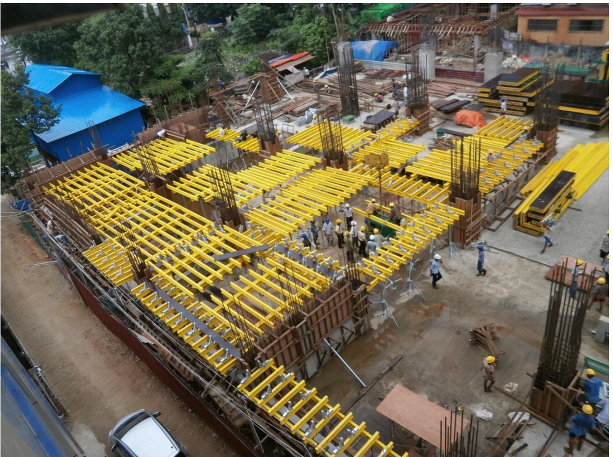
Ứng dụng ván khuôn dầm/ Beam Form Application
