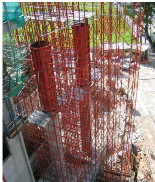
Ván khuôn thép cho cột tròn/ Circular Column Steel Form
