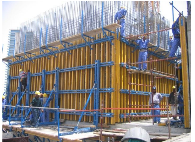
Sàn công tác chính và ván khuôn tường/ Main working platform & wall form
